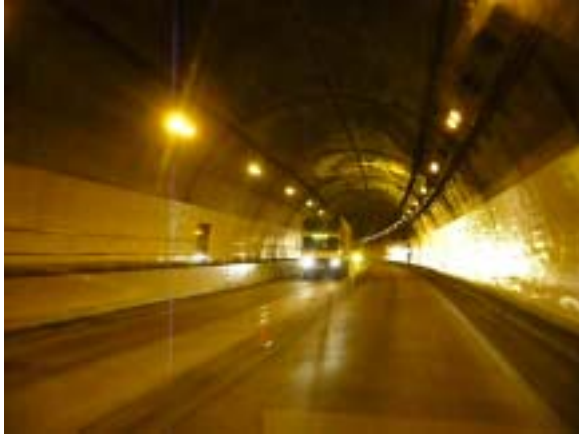
写真 22. ハイバントネル
